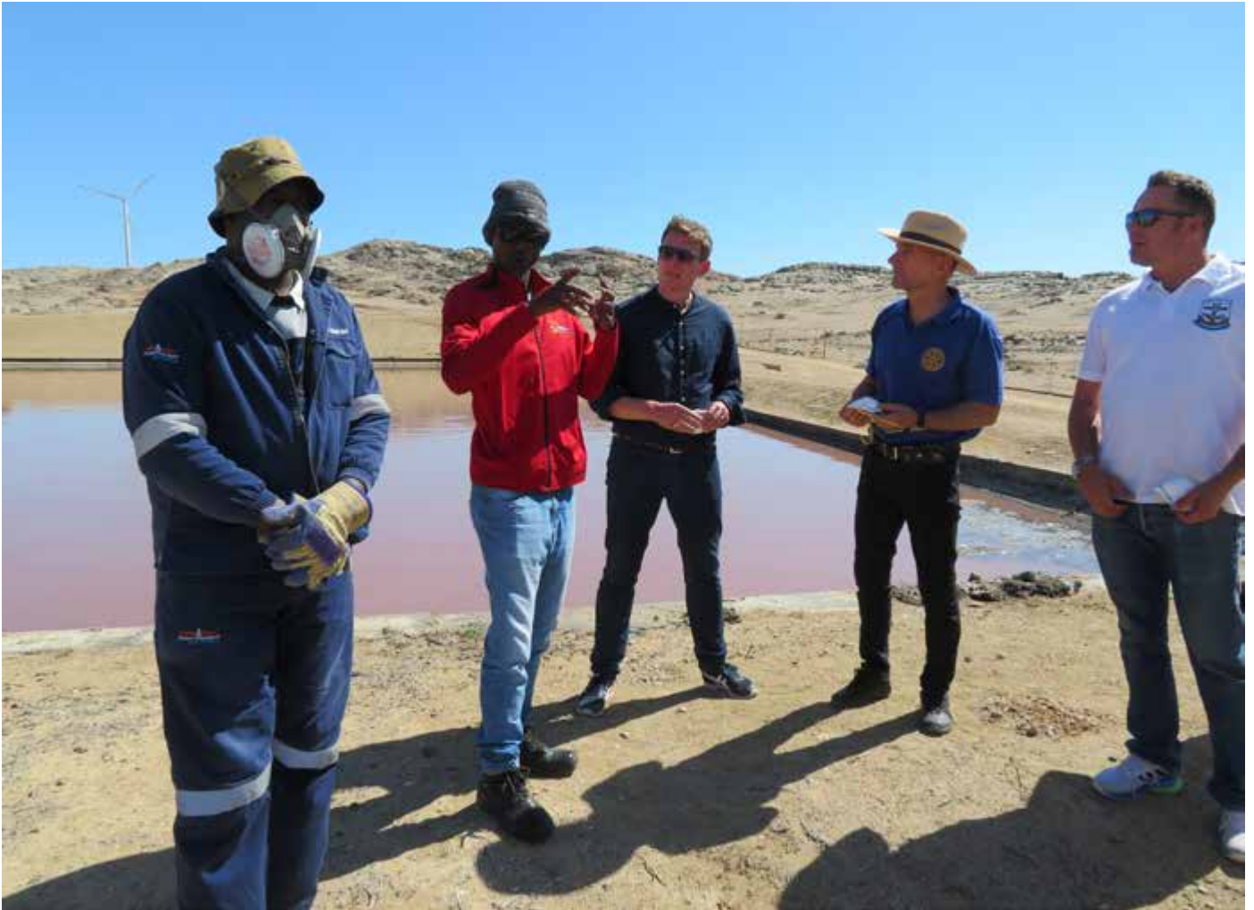
Lüderitz verfügt über eine Abwasser-Kläranlage, die mit Hilfe der Europäischen Union errichtet wurde.
